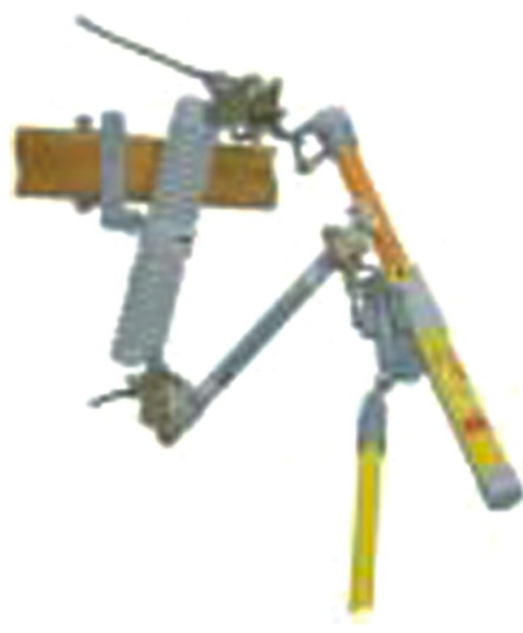
开断电力熔断器
